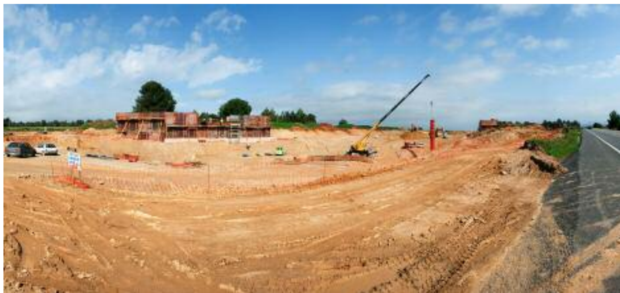
Les obres del TAV al seu pas per Pontòs.
