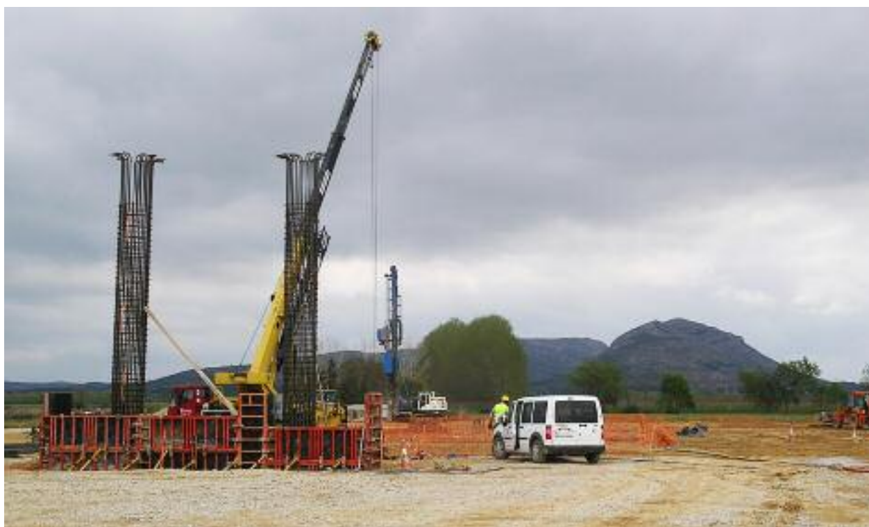
Obres a la C-31 al tram de la nova variant de la Tallada, damunt els plans agrícoles del Baix Ter.
