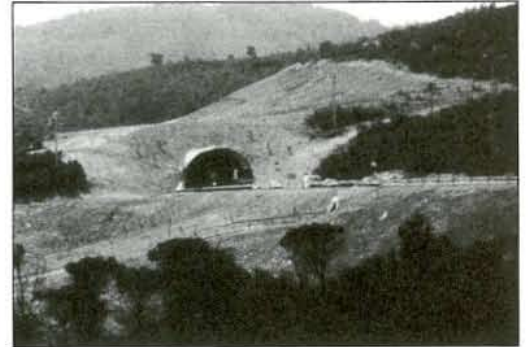
La variant de la N-II ha tallat la connexió natural de la ciutat de Girona amb el massís de les Gavarres (Foto: Ramon Fortià)
